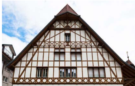
Restaurierung Fachwerk, Gutshof Gutach, Klaus Wehrle
