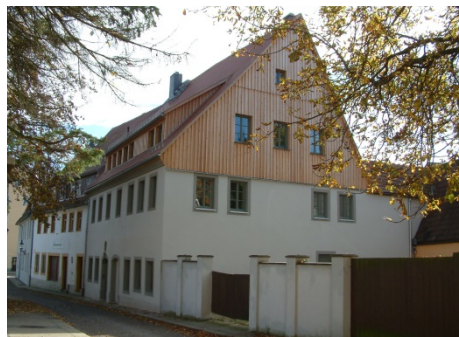
Sanierung Kesselgasse 30, Freiberg Architekturbüro Gerschler, Freiberg Foto: Uwe Gerschler
