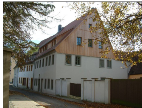
Sanierung Kesselgasse 30, Freiberg, Dipl.-Ing. Uwe Gerschler , Freier Architekt, Architekturbüro Gerschler , Freiberg
