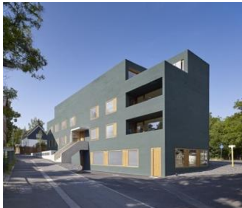
Wohn- und Geschäftshaus, Mainz H. Gies Architekt GmbH, Mainz Foto: Stefan Erbring, Köln
